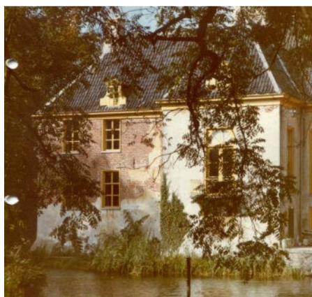
Borg voor de restauratie in 1973, deels zonder stucwerk. Drie dichtzettingen van oude vensters zijn zichtbaar in de muur van de Groene Kamer.
